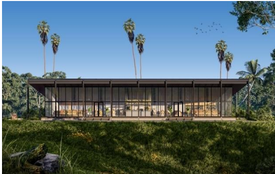
Gambar 22. Samara Signature Farm House Sumber: Dokumentasi pribadi, 2023
